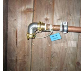
Anschluss Schlauch
