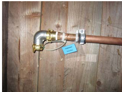
Anschluss Schlauch
